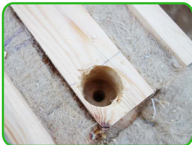
Комбинированное отверстие, под размещение пружинного блока и прохождения шурупа
