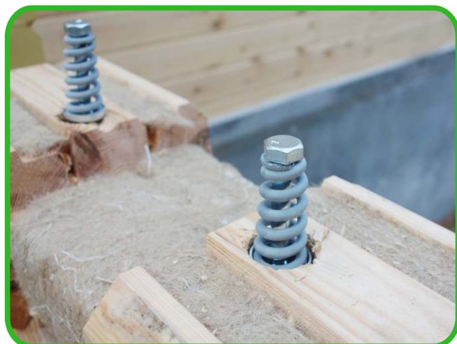
Расстановка межвенцового крепежа
