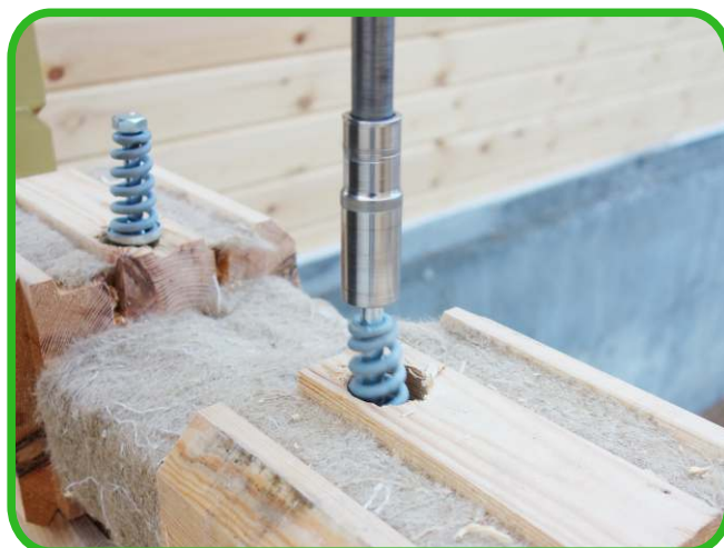
Вворачивание межвенцового крепежа
