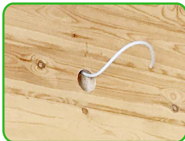
Комбинация отверстий вертикального канала и отверстия подрозетника
