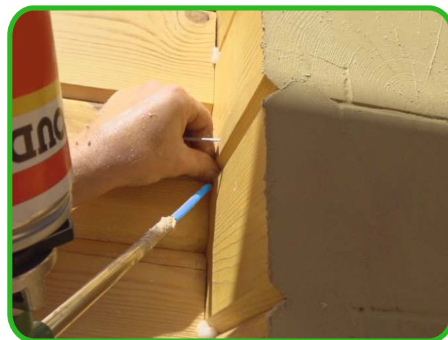
Подача пены в вертикальный канал
