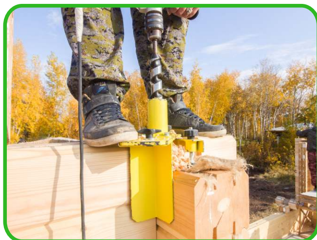
Оснастка «Теплый угол» в работе
