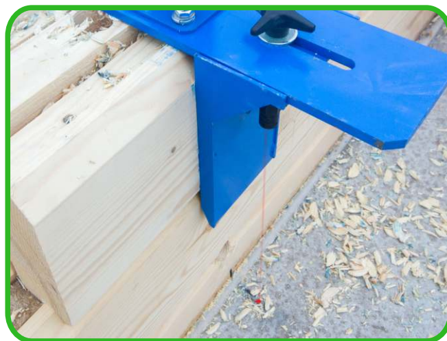
Позиционирование оснастки по отношению к разметке скрытого канала
