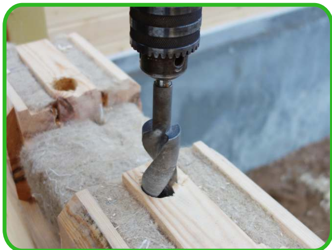
Сверление отверстия под установку межвенцового крепежа «Tedwood»
